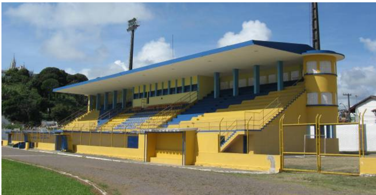
Figura 12 – Vista das arquibancadas mais antigas do Estádio Mário Pessoa a partir do campo (Foto do autor, out./2008)
