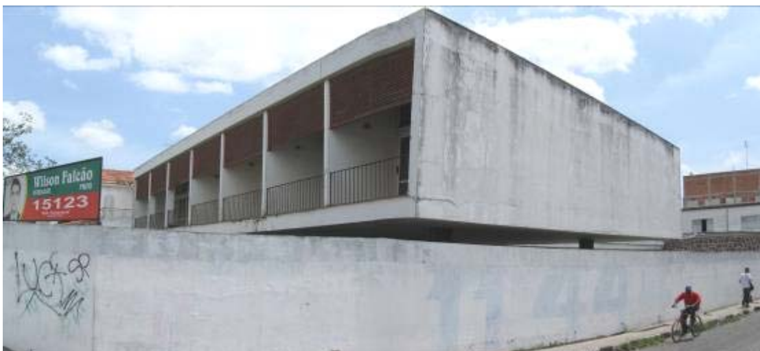
Figura 18 – Vista geral da Residência Newton da Costa Falcão em Feira de Santana (Foto do autor, out./2008)
