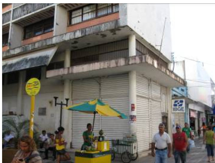
Figura 08 – Vista atual da antiga sede do Banco da Bahia (Foto do autor, out./2008)
