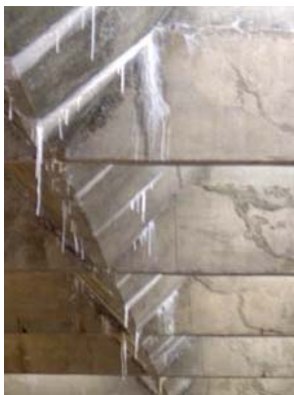
Figura 5: Estalactites da cobertura, decorrentes das reações químicas do concreto em contato com a água
