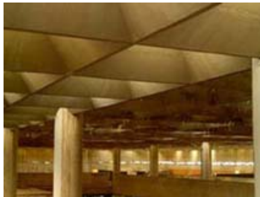
Figura 2: A continuidade espacial característica da FAUUSP. Em primeiro plano, parte da estrutura de cobertura já recuperada.
