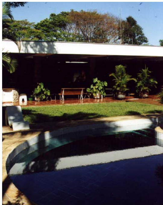
Foto 03: Fachada Interna da Residência do Arquiteto Pinho
