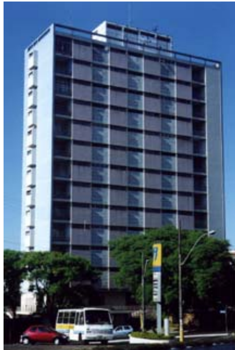
Foto 01: Fachada do Edifício Brasil-Portugal
