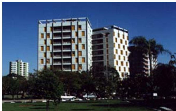
Foto 05: Fachada do Edifício Vila Real
